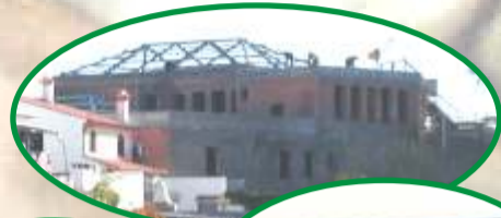
PORMENOR DA ESTRUTURA METÁLICA, COBERTURA DA BIBLIOTECA MUNICIPAL
